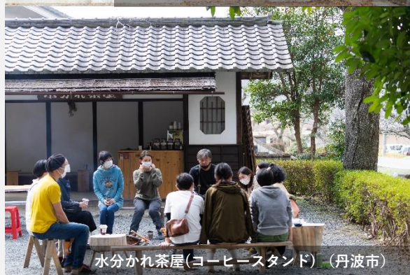
改修後の空き家(参考事例) (丹波市)
